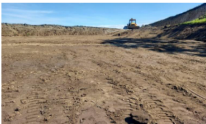
Figura # 16. Compactación de estructuras del reservorio por medio de maquinaria. Zona Guanacaste, Costa Rica, 2021.
