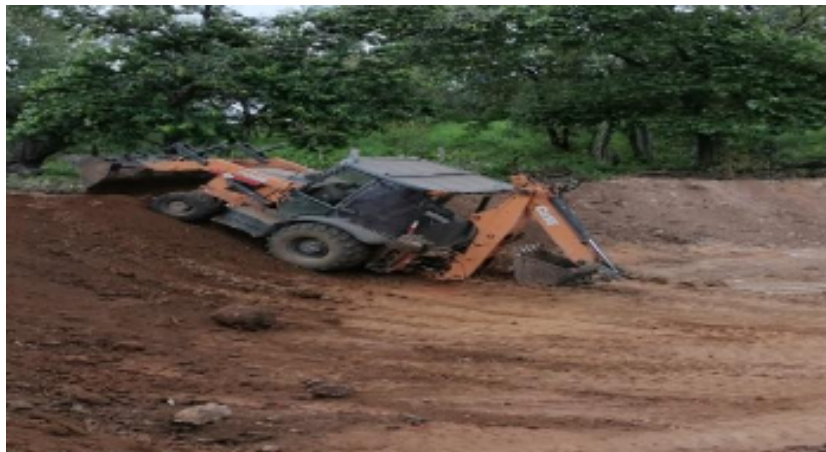
Figura 15: Excavación del reservorio. Zona Guanacaste, Costa Rica, 2021.
