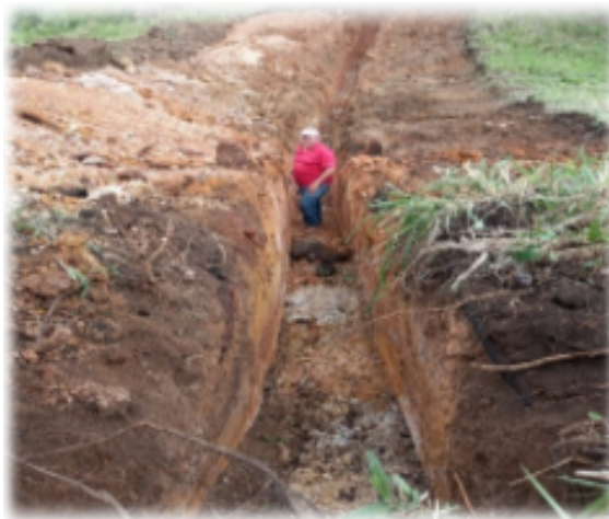
Figura 12: Vista lateral del dique. Zona Guanacaste Costa Rica, 2021.
