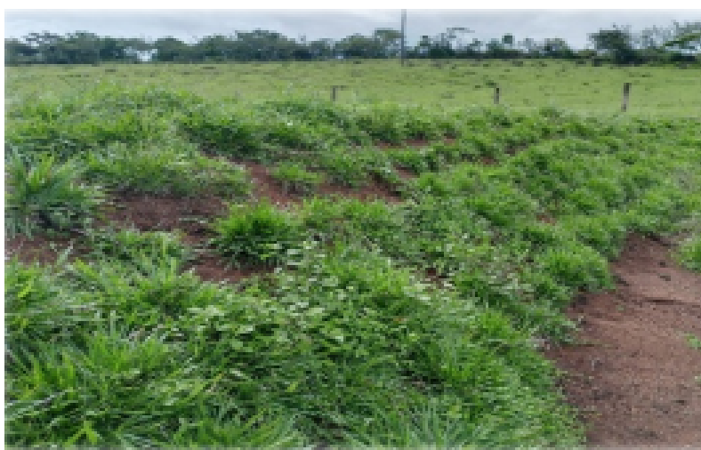
Figura # 18. Pastos plantados en taludes de reservorio construido en zona de Guanacaste, Costa Rica, 2021.
