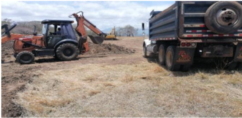
Figura 14. Maquinaria usada en construcción de reservorio. Zona Guanacaste, Costa Rica, 2021.
