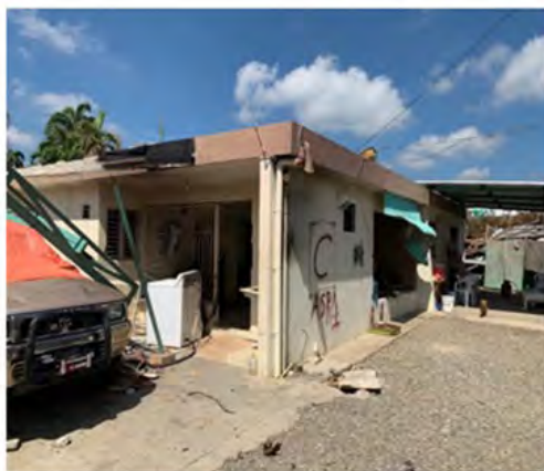
Foto No. 8 Vivienda Afectada
