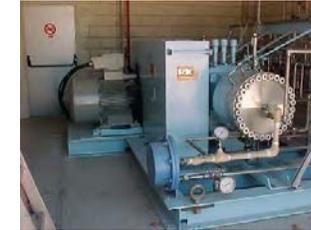
**3 Compresores** un compresor que opere a 30 bar y dos compresores que operen hasta 500 bar.
