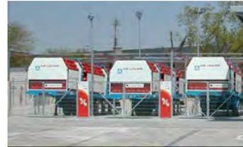
**Sistema de almacenamiento** con una capacidad máxima de unos 600 kg de hidrógeno (2 tanques a 300 y 500 bar)
